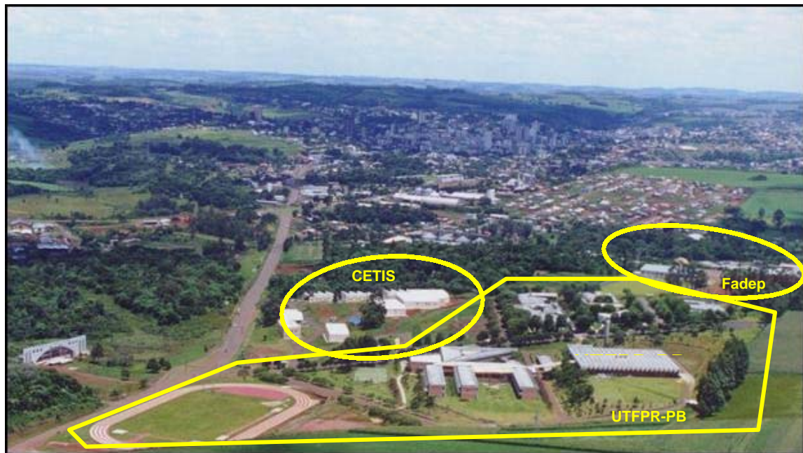
FIGURA 1 - VISTA AÉREA DO CETIS E DA UTFPR EM PATO BRANCO - 2006
