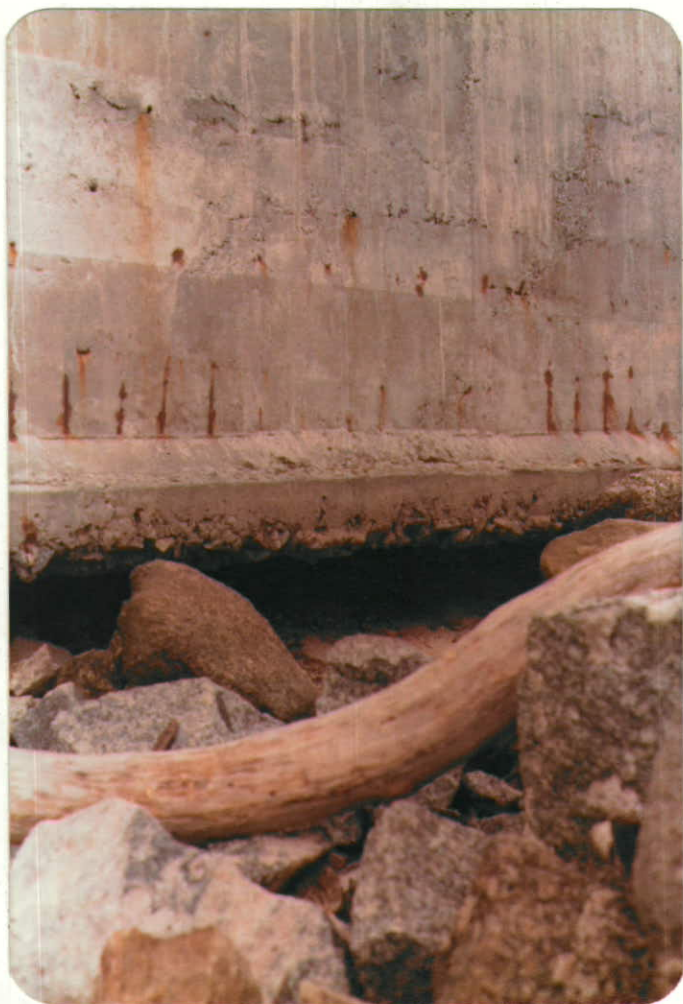
FOTO 5 - Fundação da ponte descalçada pela ação das ondas e das águas do canal.
