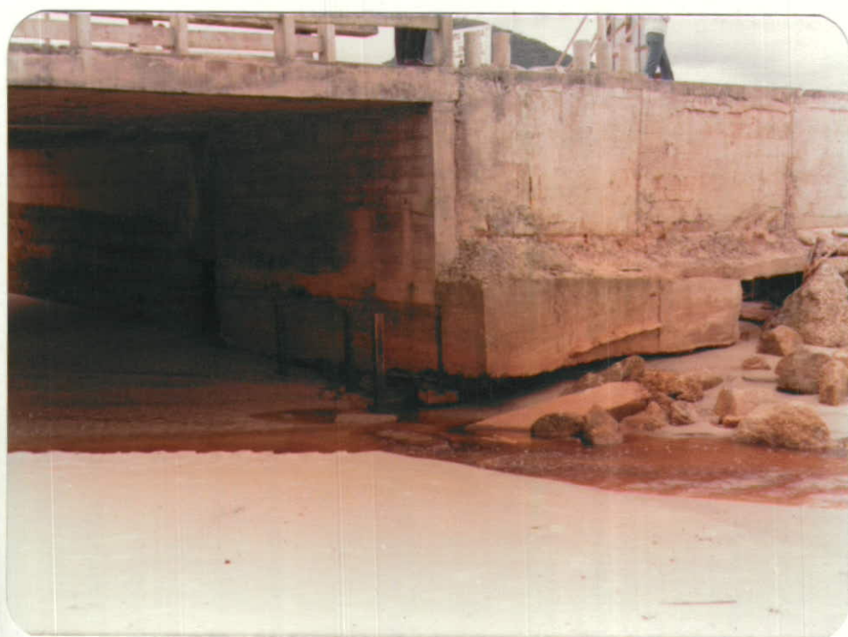
FOTO 5 - Fundação da ponte descalçada pela ação das ondas e das águas do canal.
