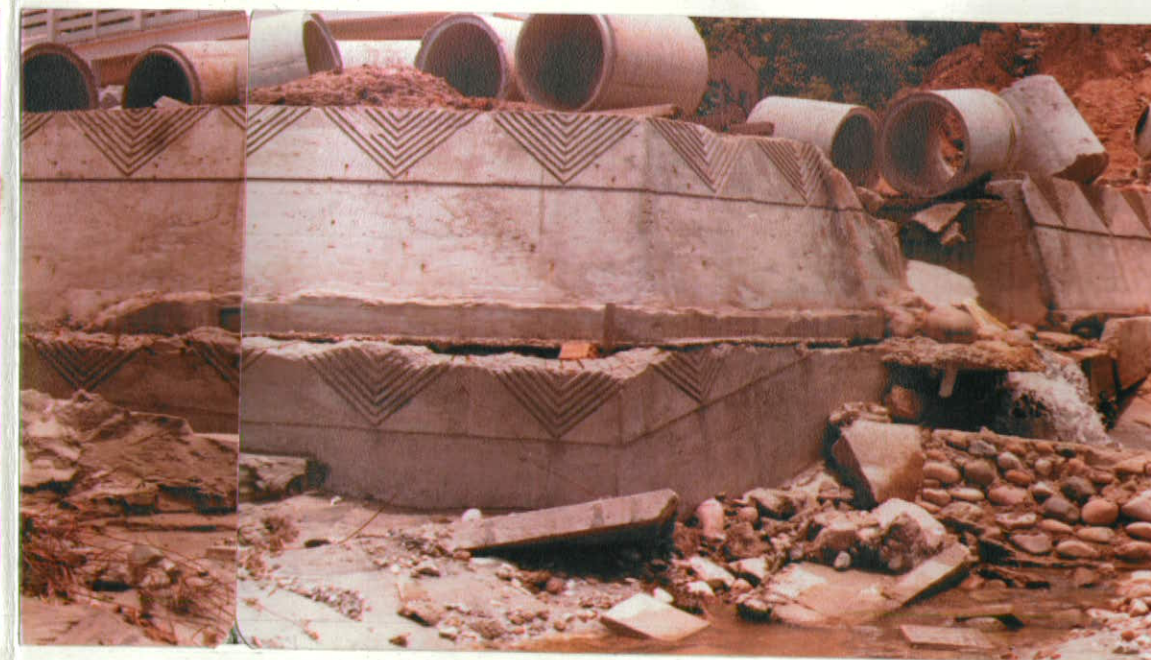
FOTO 16 - Extremo norte do "calçadão". O maior volume de água escorre por baixo da estrutura e não pela drenagem da obra. Muro construído sem sustentação efetiva e reconstruído com característica idênticas. → Direção do Fluxo
