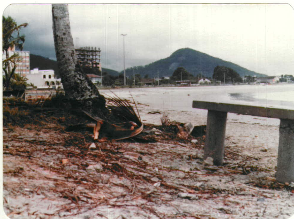
FOTO 11 - Raízes de palmeiras em superfície indicando erosão.
