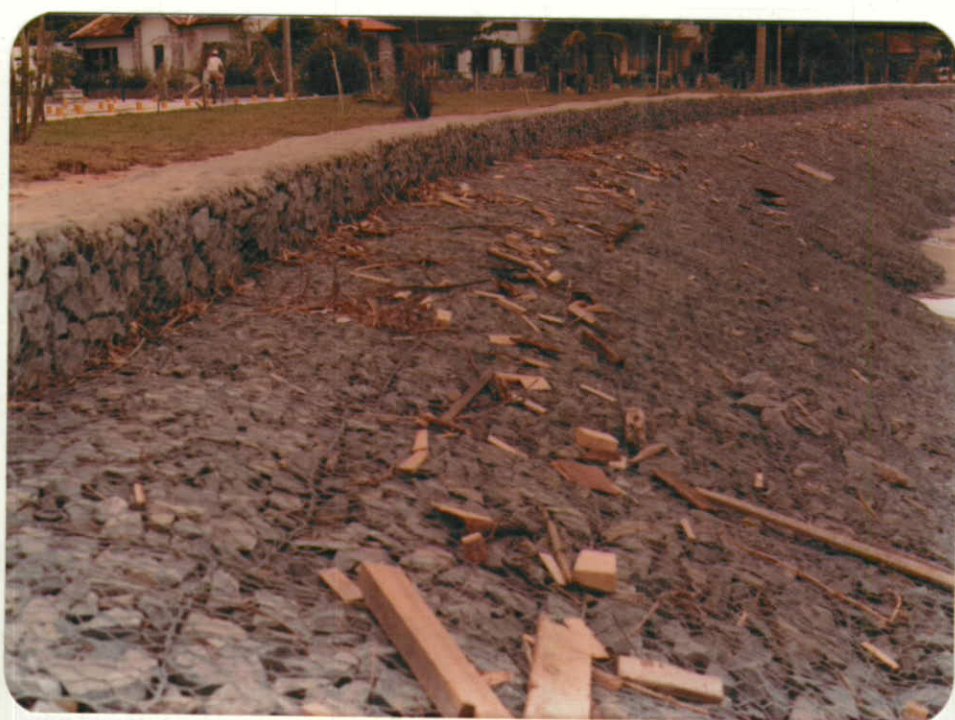
FOTO 15 - Material deixado pelas ondas sobre gabiões.
