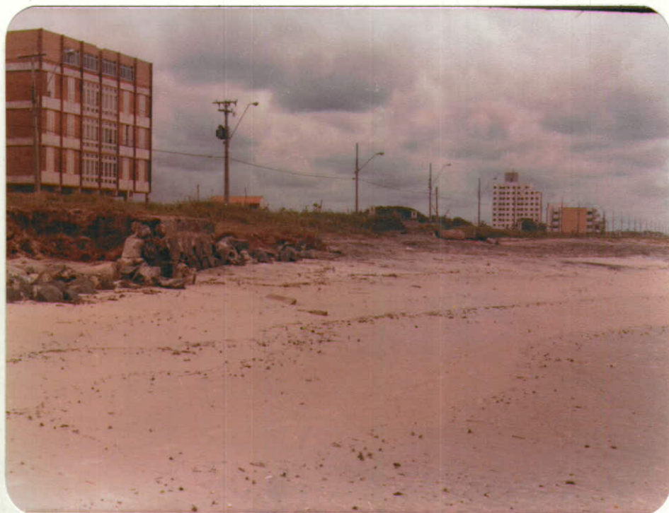
FOTO 8 - Extremo norte da Zona I - não se observa erosão além dos limites da construção do muro de contenção.
