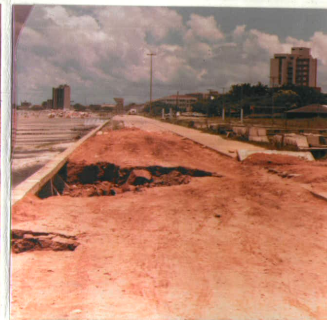
FOTO 18 - Fugas de material do aterro distribuído em forma de leque. → Direção do Fluxo
