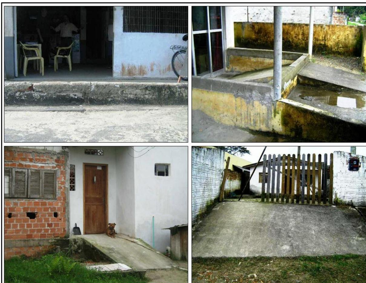
FIGURA 64 – OBRAS DESTINADAS A CONTENÇÃO DE ÁGUA DURANTE A OCORRÊNCIA DE INUNDAÇÕES – SAUM/TABULEIRO I E II-VILA NOVA – MATINHOS: 2009
