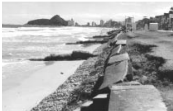
FIGURA 4 - VISTA PARA O SUL DA PRAIA BRAVA DE CAIOBÁ, MOSTRANDO MUROS E ESPIGÕES DE GABIÕES DESTRUÍDOS PELAS ONDAS
