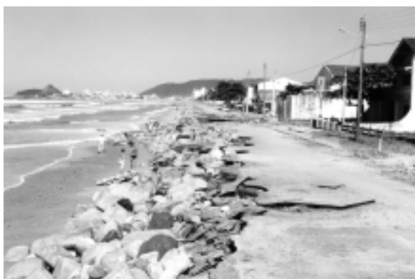
FIGURA 3 - ENROCAMENTOS CONSTRUÍDOS NO BALNEÁRIO FLAMINGO, EM FRENTE À AVENIDA BEIRA-MAR
